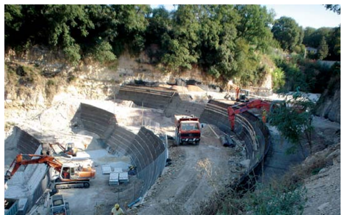
Rivestimento alveo e realizzazione gradoni
