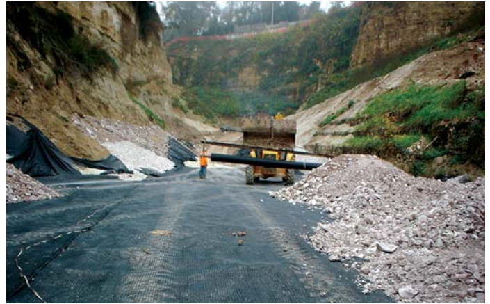
Stesa dei teli di rinforzo del rilevato
