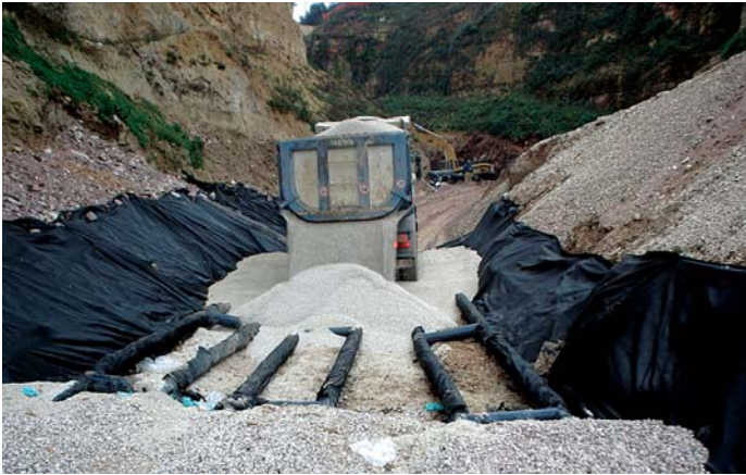
Realizzazione dei drenaggi di fondo
