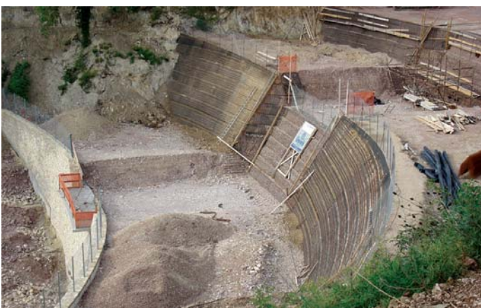
Realizzazione delle bermes
