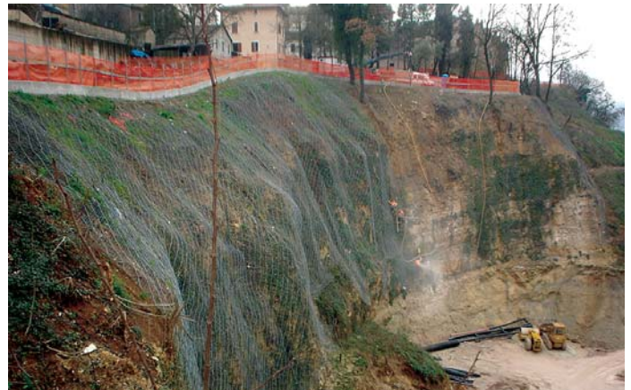
Perforazioni in parete per il rafforzamento corticale
