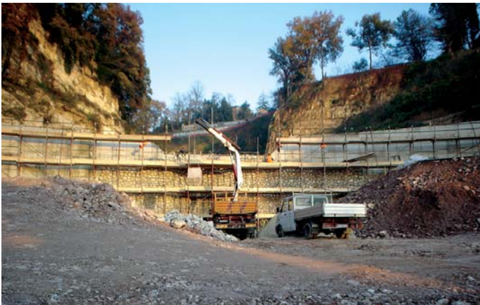
Muro di Valle - Rivestimento in pietra
