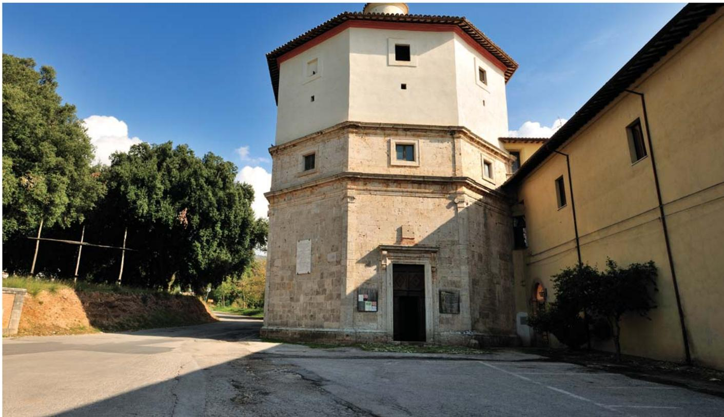
L'intervento proposto nel progetto, ha riguardato la ristrutturazione, il consolidamento e il rifacimento delle principali strutture del corpo ottagonale della Chiesa delle murature portanti del tiburio e delle pareti esterne, il consolidamento della volta a botte della parte absidale, della volta a padiglione e dei solai.
