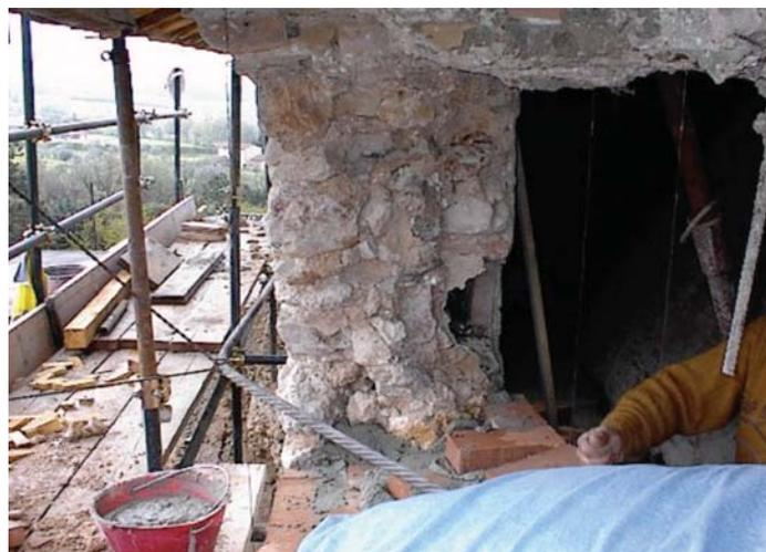
a circa 1 m, e ricostruendole utilizzando il materiale idoneo di risulta e mattoni pieni, con ammorsature efficaci con i tratti consolidati con iniezioni.
