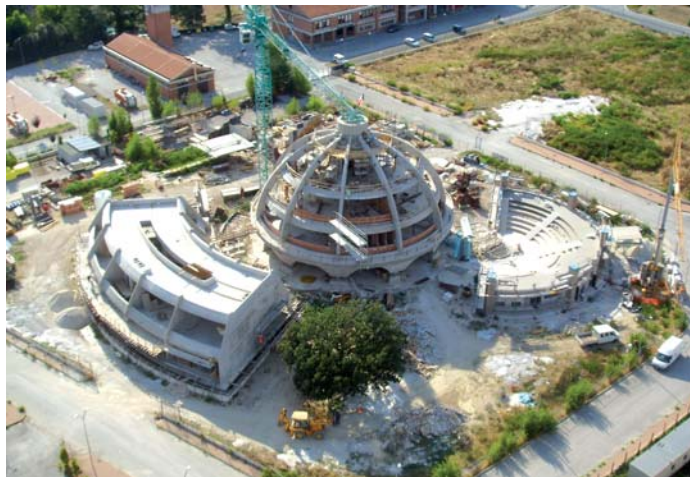
Cantiere con strutture ultimate - vista dall'alto
