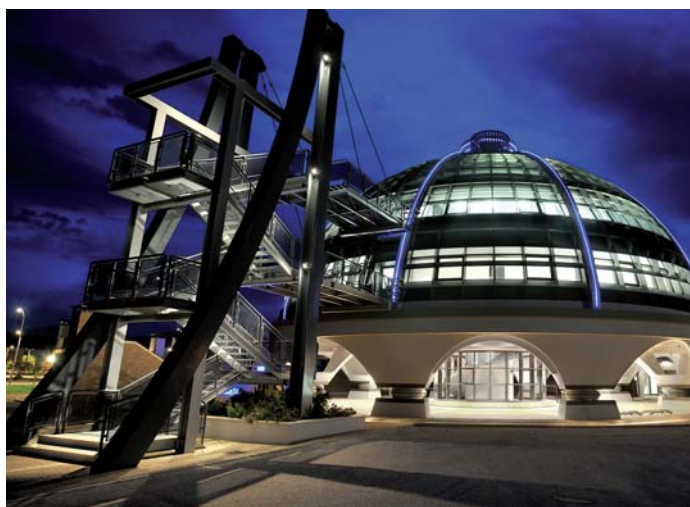
Scala di emergenza e sala operativa
