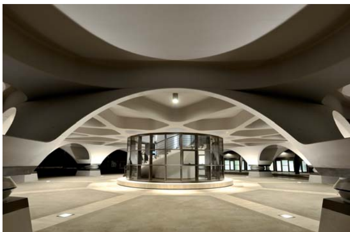
Arcate e travi del primo solaio. Vano scale/ascensore
